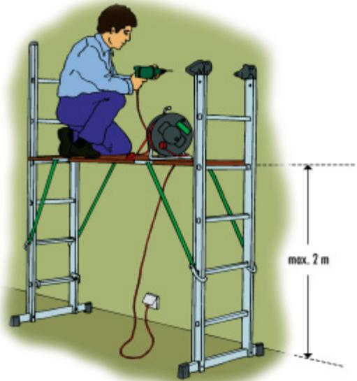
Für viele Arbeiten, z. B. solche, die mit größerem Arbeitsaufwand verbunden sind oder wenn durch den Einsatz von Elektrowerkzeugen Kräfte aufzubringen sind, empfiehlt sich der Einsatz eines Kleingerüsts.
